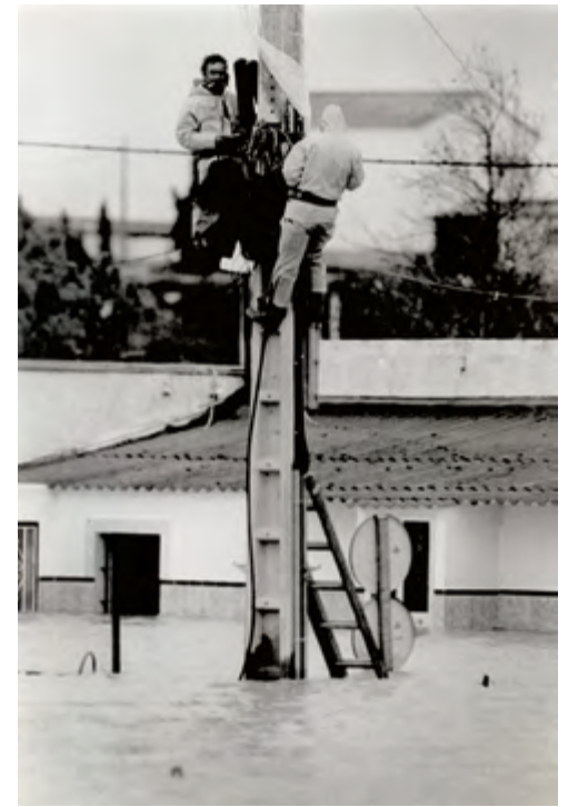
Poste telefónico afectado por una inundación. Fotografía de Carlos Santos.
